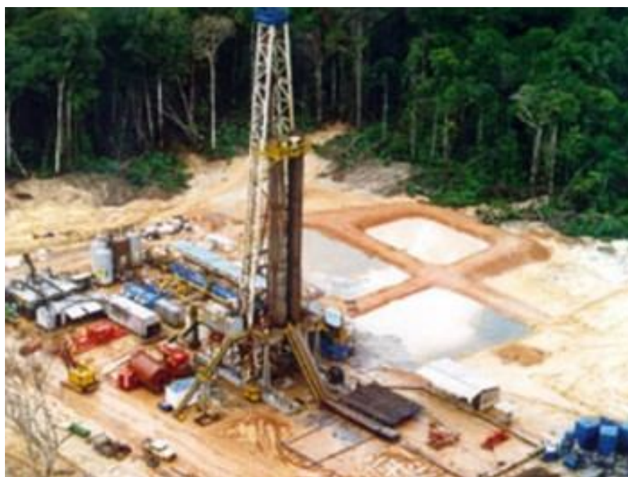
Figura 8 – Perfuração do poço 1-BRSA-961-AM
