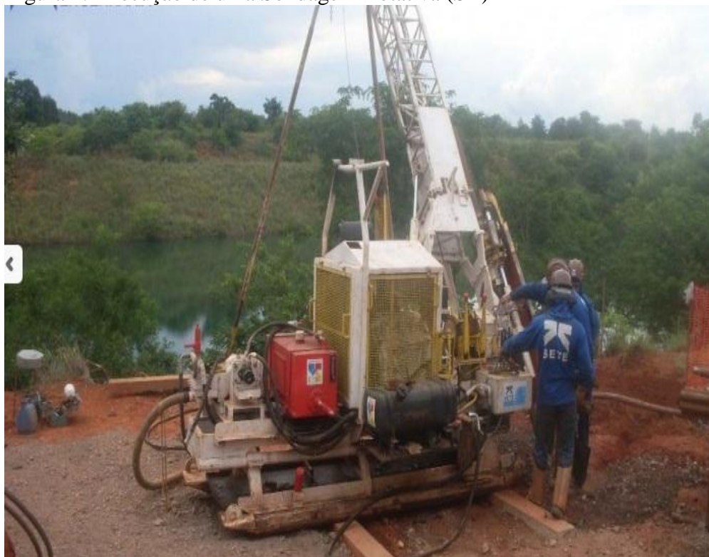
Figura 4: Execução de uma Sondagem Rotativa (SR)
