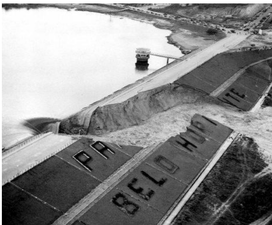
Figura 5: Fenômeno do Entubamento
