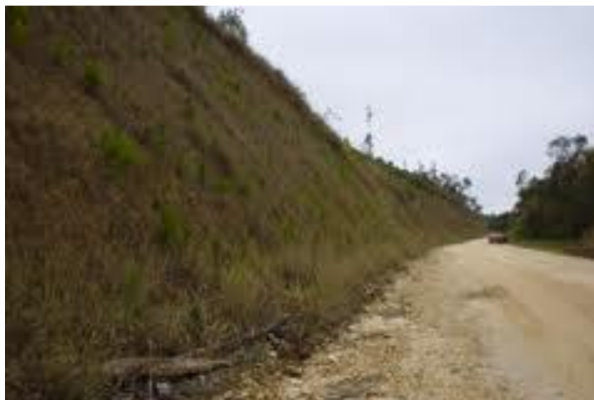
Figura 8: Proteção Superficial do talude de corte.
